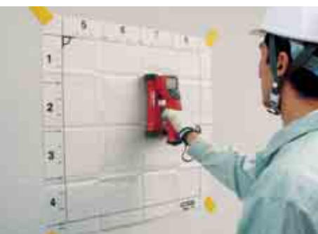
使用例1：建築物の構造確認に (イメージスキャンによる鉄筋位置・本数・かぶり厚の確認)
