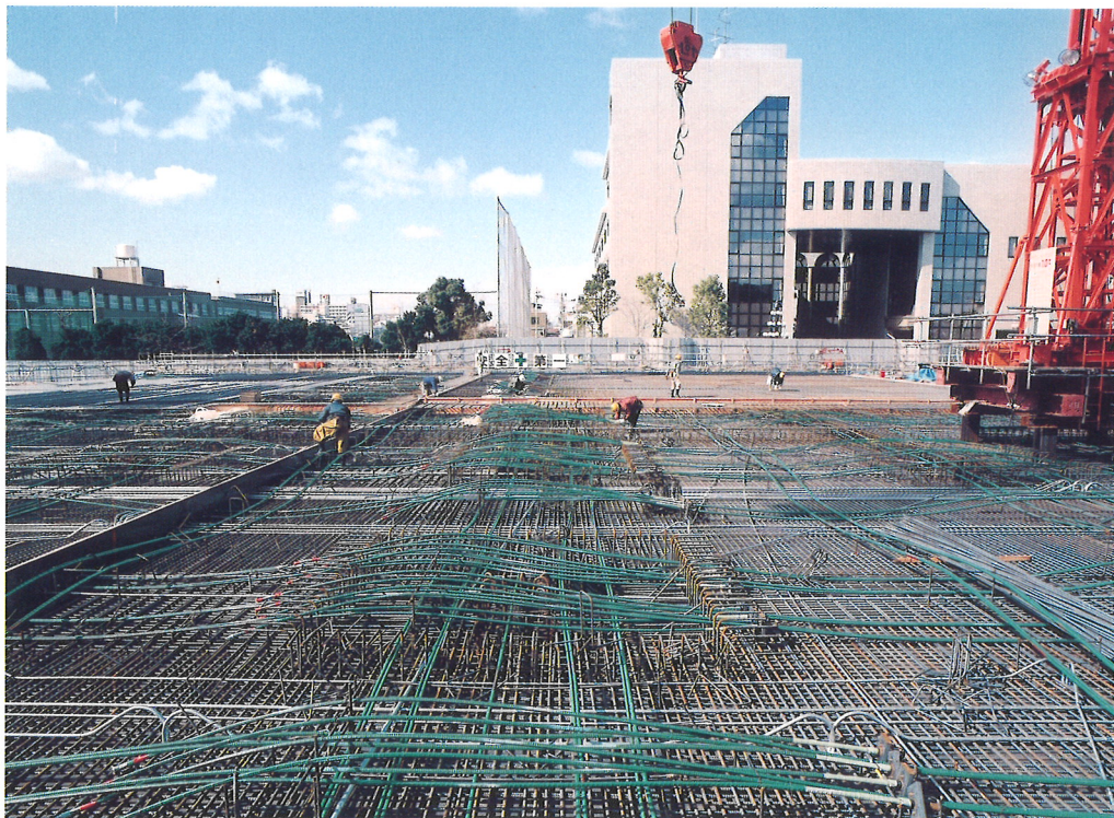
地下駐車場のPC鋼線配線状況
