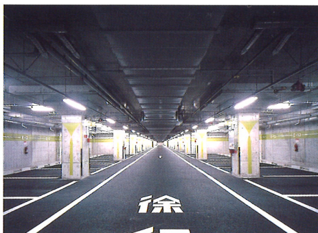
地下駐車場の状況
