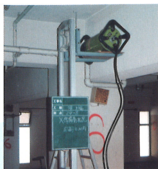
梁の撮影状況
