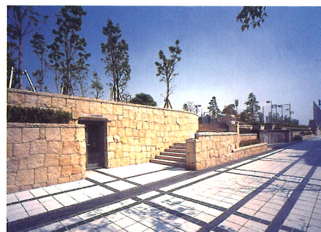
地下駐車場上部（公園）の状況
